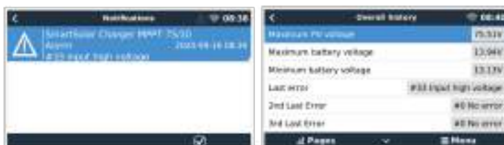
GX-apparaat met alarmmelding en historische fouten.
