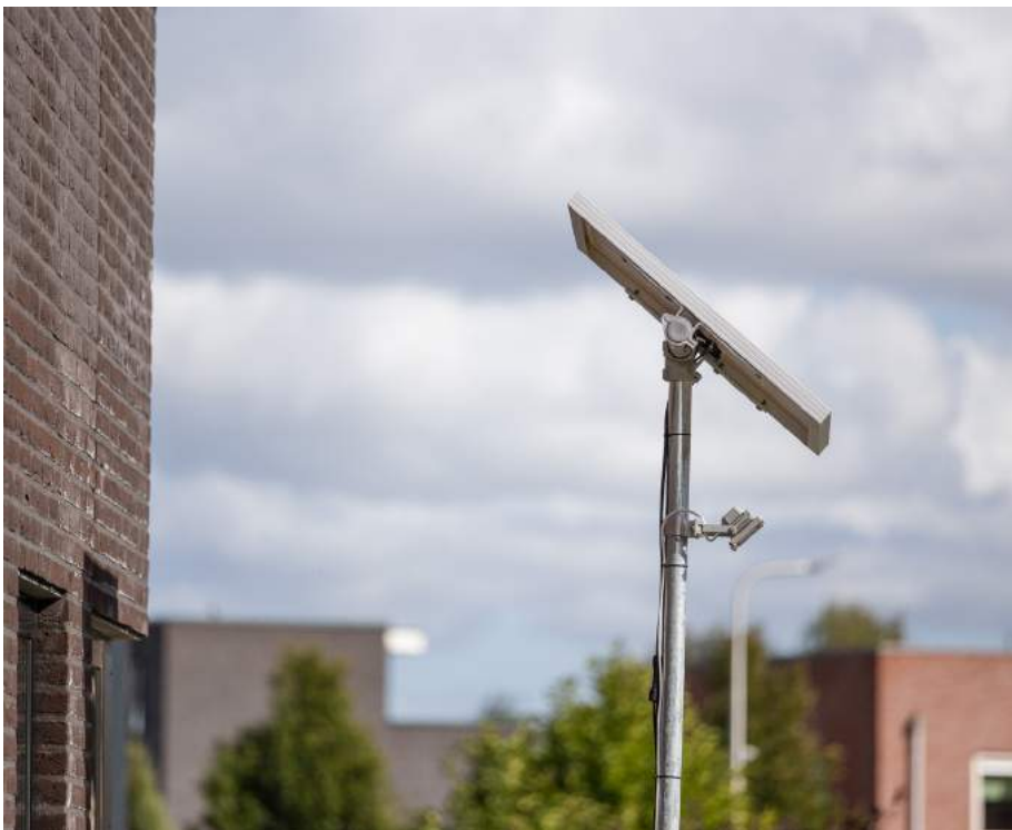
80 Watt piek zonnepaneel met een schijnwerper voor de verlichting van de naamzuil van Cedel B.V.
