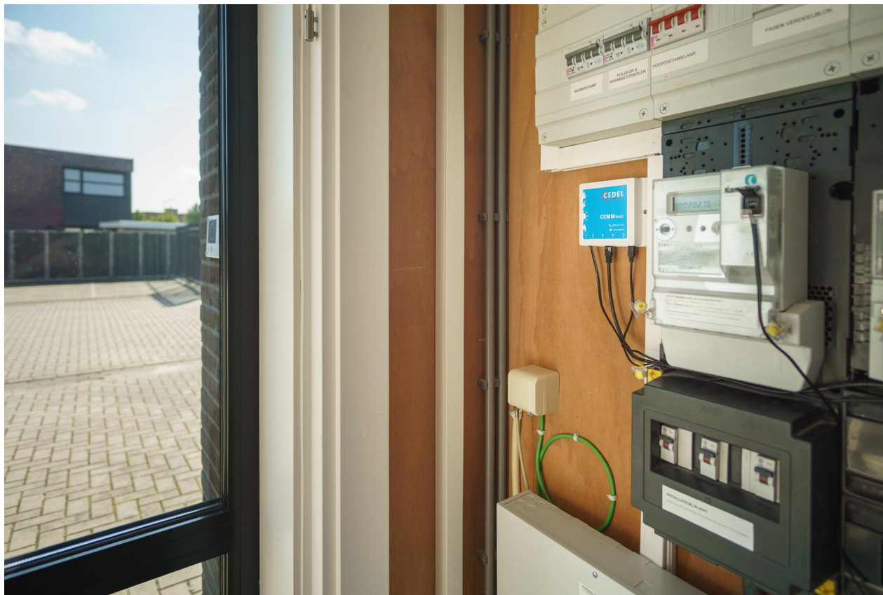
CEMM basic in de meterkast van Cedel B.V.
