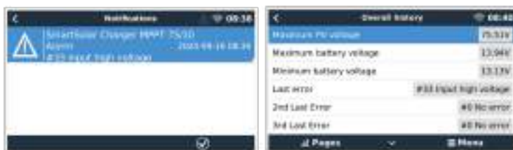
GX-apparaat met alarmmelding en historische fouten.
