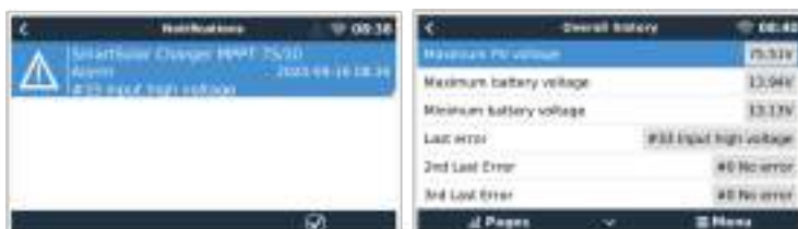
GX-apparaat met alarmmelding en historische fouten.
